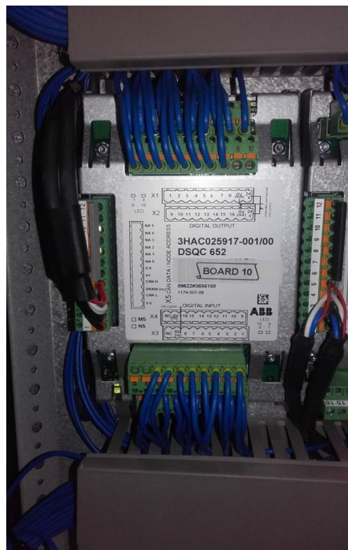
Slika 5 I/O kartica sa spojenim signalima
