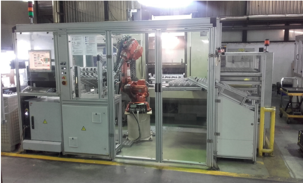
Slika 33. Prikaz zaštitne ograde
