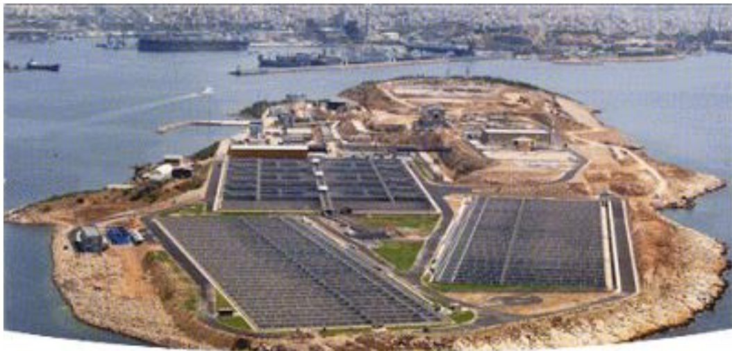
Slika 41: Postrojenje za obradu otpadnih voda
