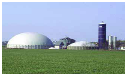
Slika 39: Postrojenje za proizvodnju bioplina na farmi, kodigestija stajskog gnoja i energetskih usjeva
