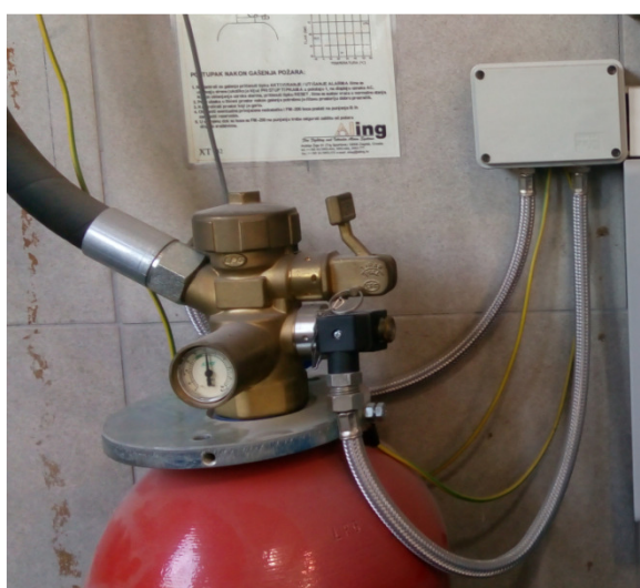
Sl. 39. Prikaz ventila na spremniku plina FM-200
