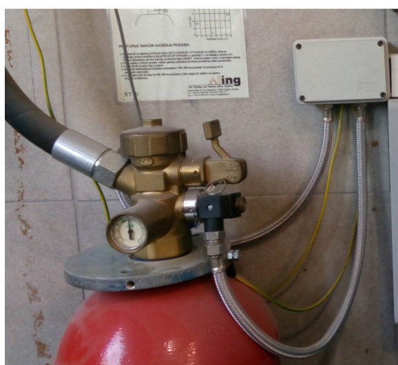
Sl. 39. Prikaz ventila na spremniku plina FM-200
