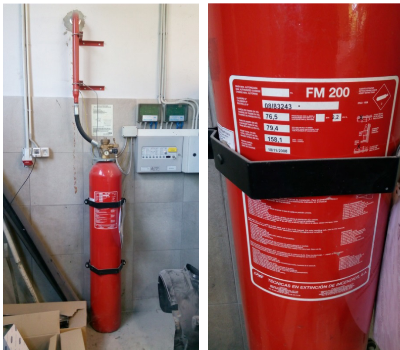
Sl. 38. Prikaz spremnika plina FM-200 za gašenje požara u komori za lakiranje
