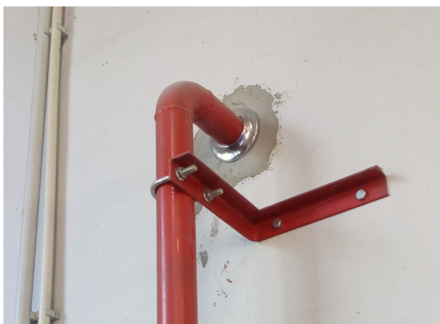
Sl. 40. Prikaz prolaza cjevovoda kroz protupožarni zid
