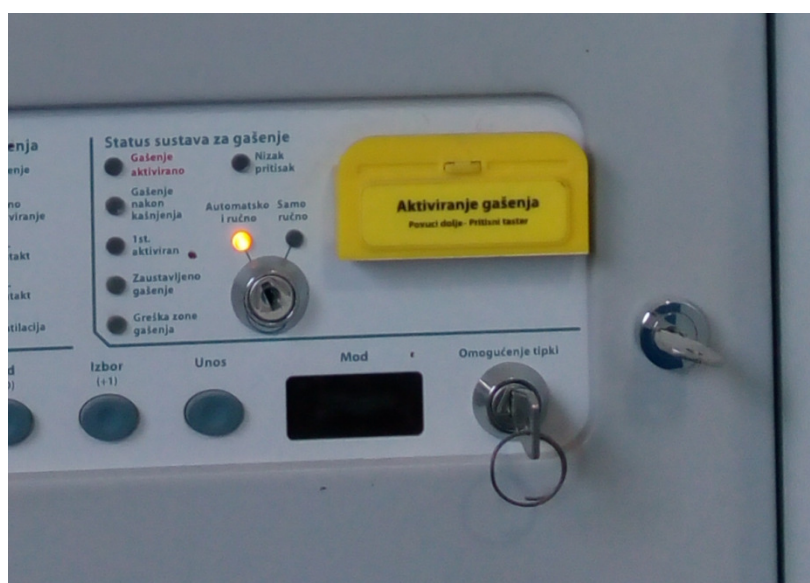
Sl. 46. Prikaz položaja tipkala za ručnu aktivaciju gašenja na centrali za gašenje
