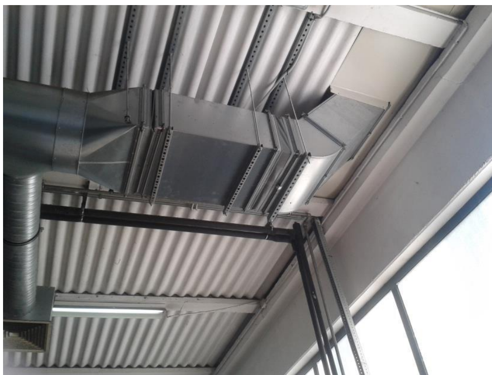
Slika 5.5. Apsorpcijski prigušivač zvuka
