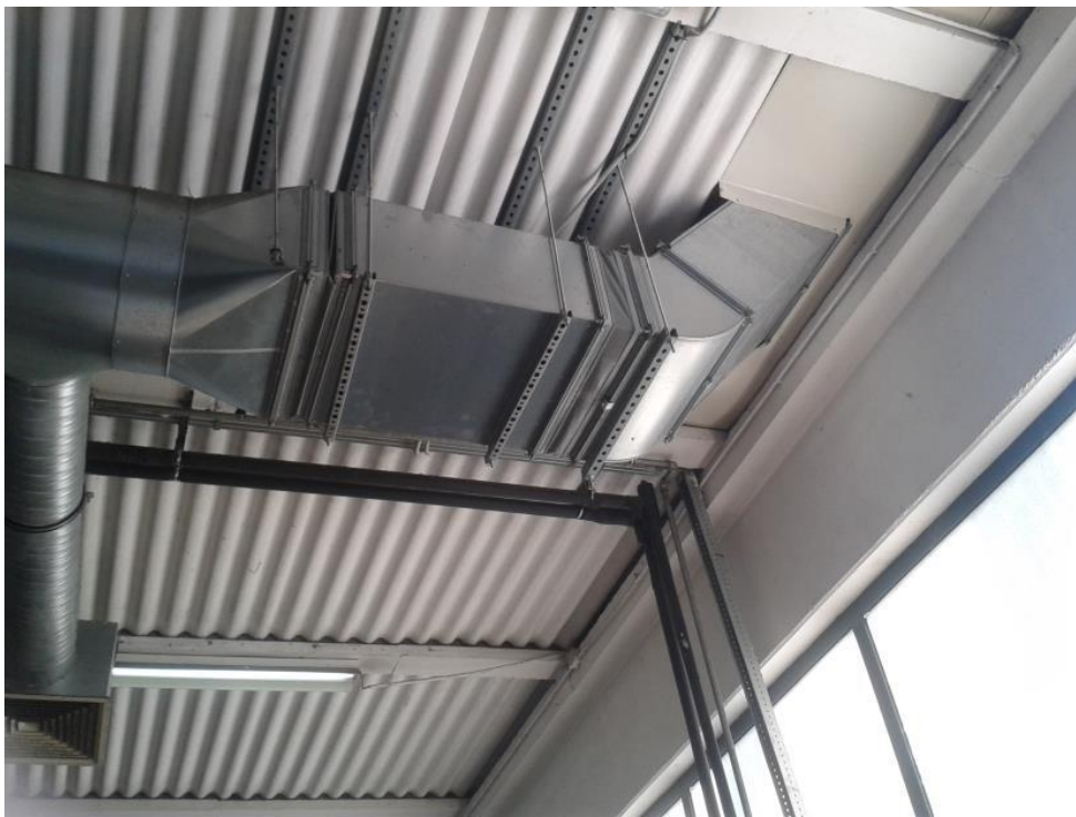
Slika 5.5. Apsorpcijski prigušivač zvuka
