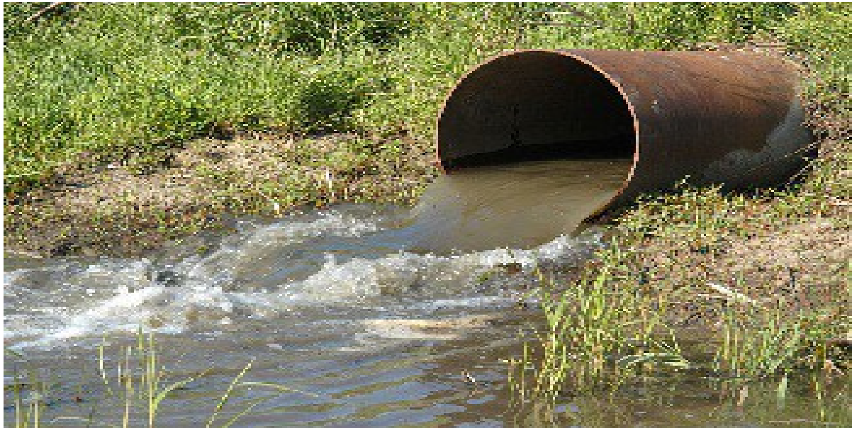
Slika 1. Prikaz neadekvatnih objekata za odvodnju otpadnih voda [2].
