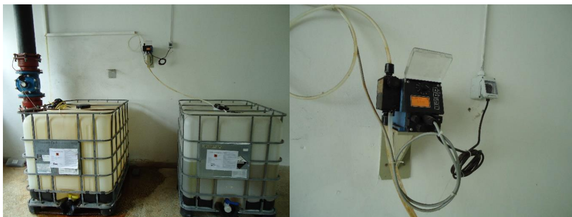
Slika 5. - Aluminijev poliklorid i uređaj za doziranje
