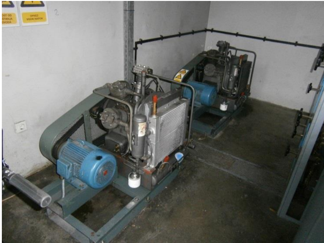
Slika 15. Kompresori LMF V15
