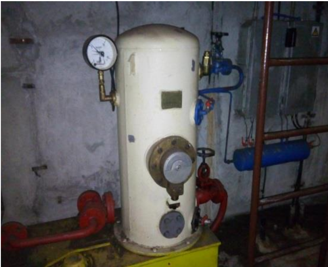
Slika 17. Spremnik za kočenje generatora
