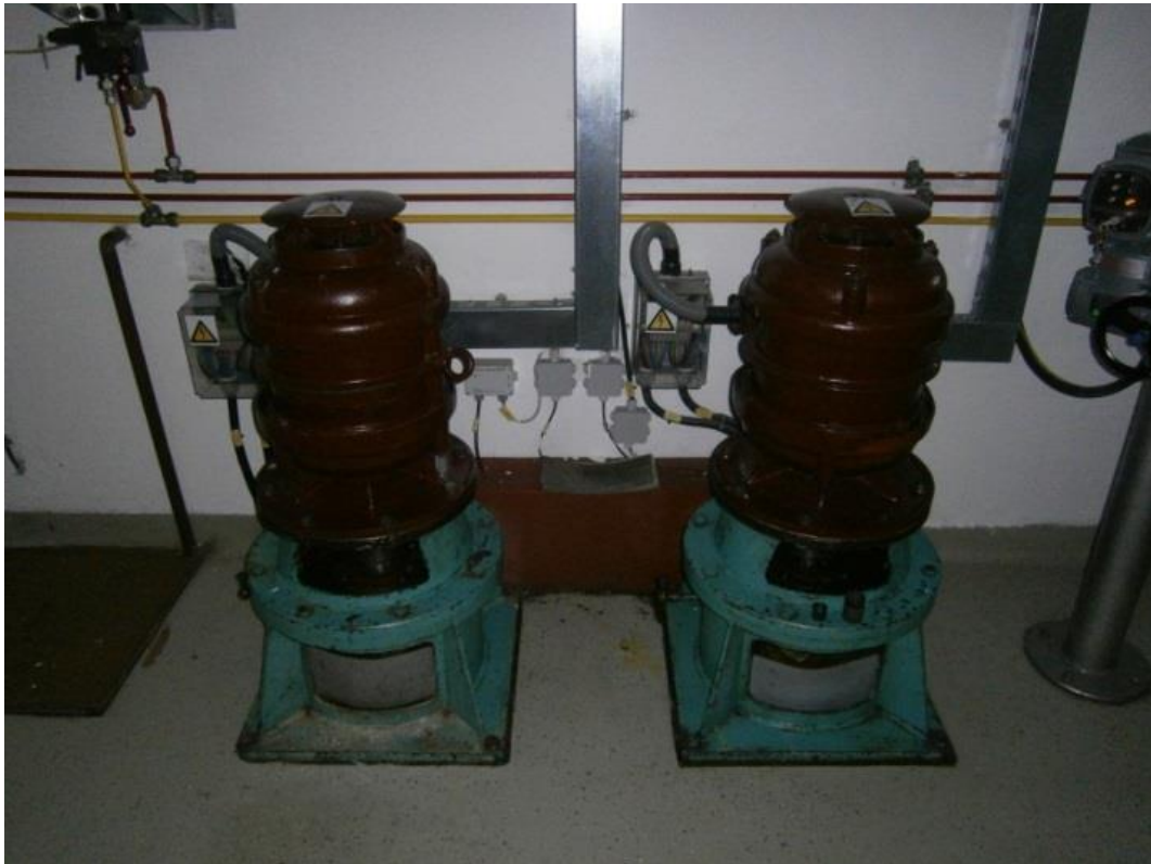
Slika 6. Drenažne crpke
