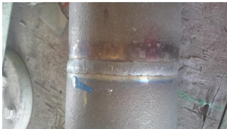
Slika 10. Pregled zavarenog spoja Vizualnom kontrolom [11]
