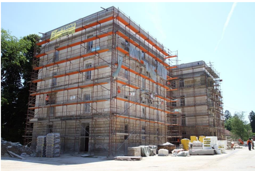
Slika 8 Prikaz postavljenih skela na gradilištu
