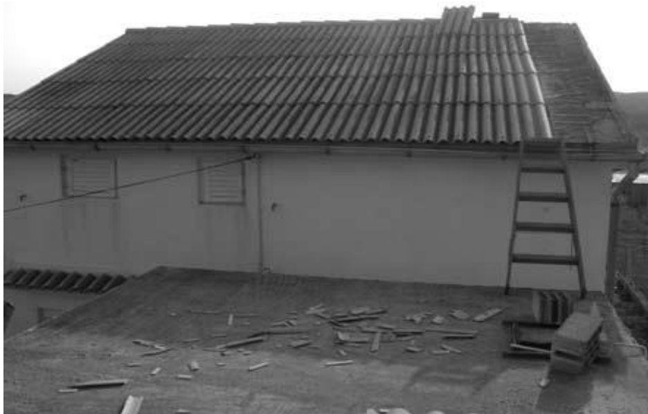
Slika 33 Prikaz krivo postavljenih ljestvi za rad [Čižmar, Đ. (2010). SMRTNA OZLJEDA RADNIKA NA PRIVREMENOM GRADILIŠTU. Sigurnost : časopis za sigurnost u radnoj i životnoj okolini, 52(2), 169-171. Preuzeto s http://hrcak.srce.hr/70254 ]
