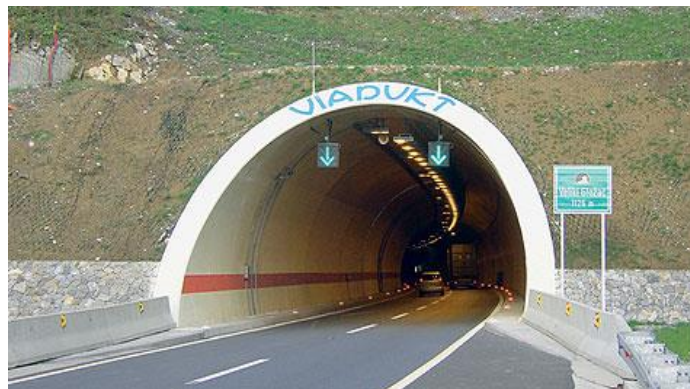
Slika 1: Tunel Veliki Gložac (južna cijev) [3]
