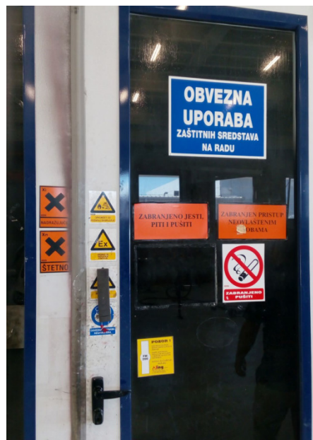
Sl. 49. Prikaz oznaka obveza, zabrane i upozorenja na ulazu u komoru za lakiranje
