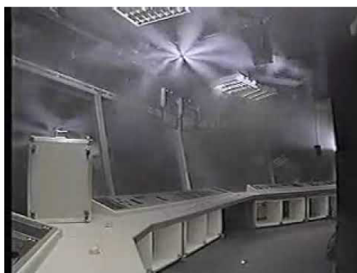
Sl. 30. Primjer raspršivanja plina FM-200 s mlaznicom
