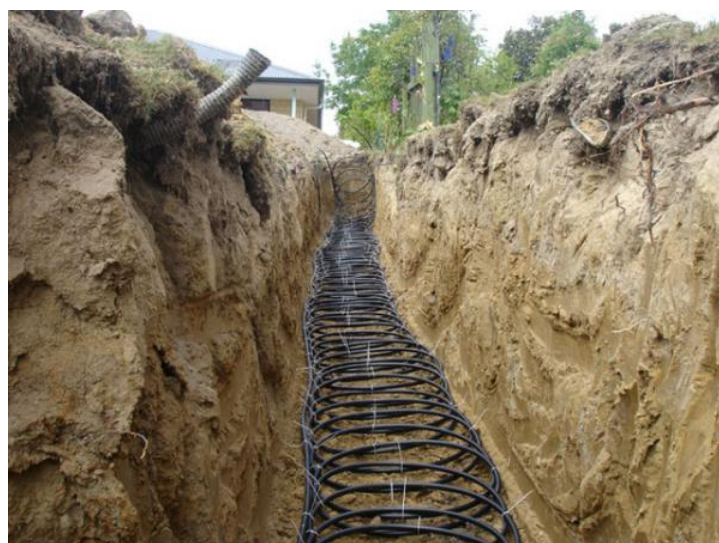
Slika 17. Spiralni kanalni kolektor u jarku [4]
