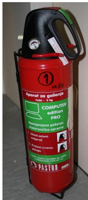
Sl. 20. Aparat za gašenje požara Fe36 na ulazu u serversku sobu s južne strane [14]
