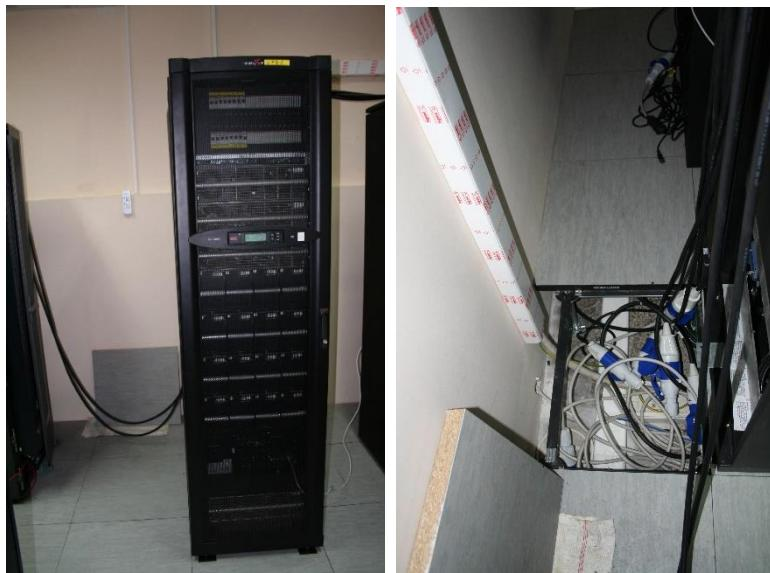
Sl. 19. Ormar sa baterijama (UPS) za rezervno napajanje i kablovi iza UPS ormara [14]
