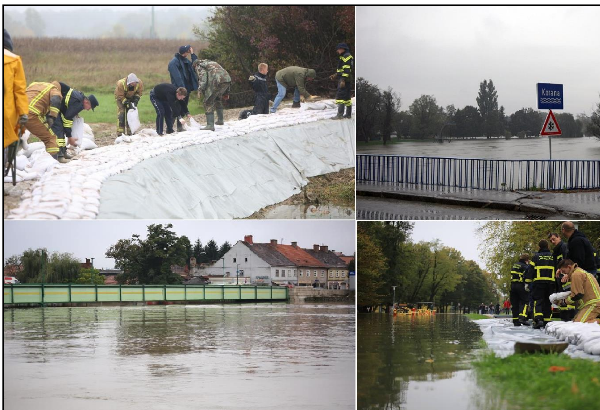
Sl. 20. Gradnja zečjih nasipa [18]
