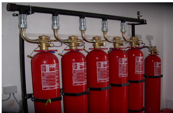
Slika 11. Sistemi za gašenje plinom Novec 1230
