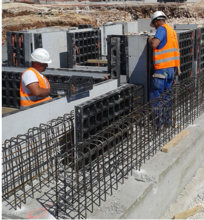
Sl. 7. Postavljanje oplata
