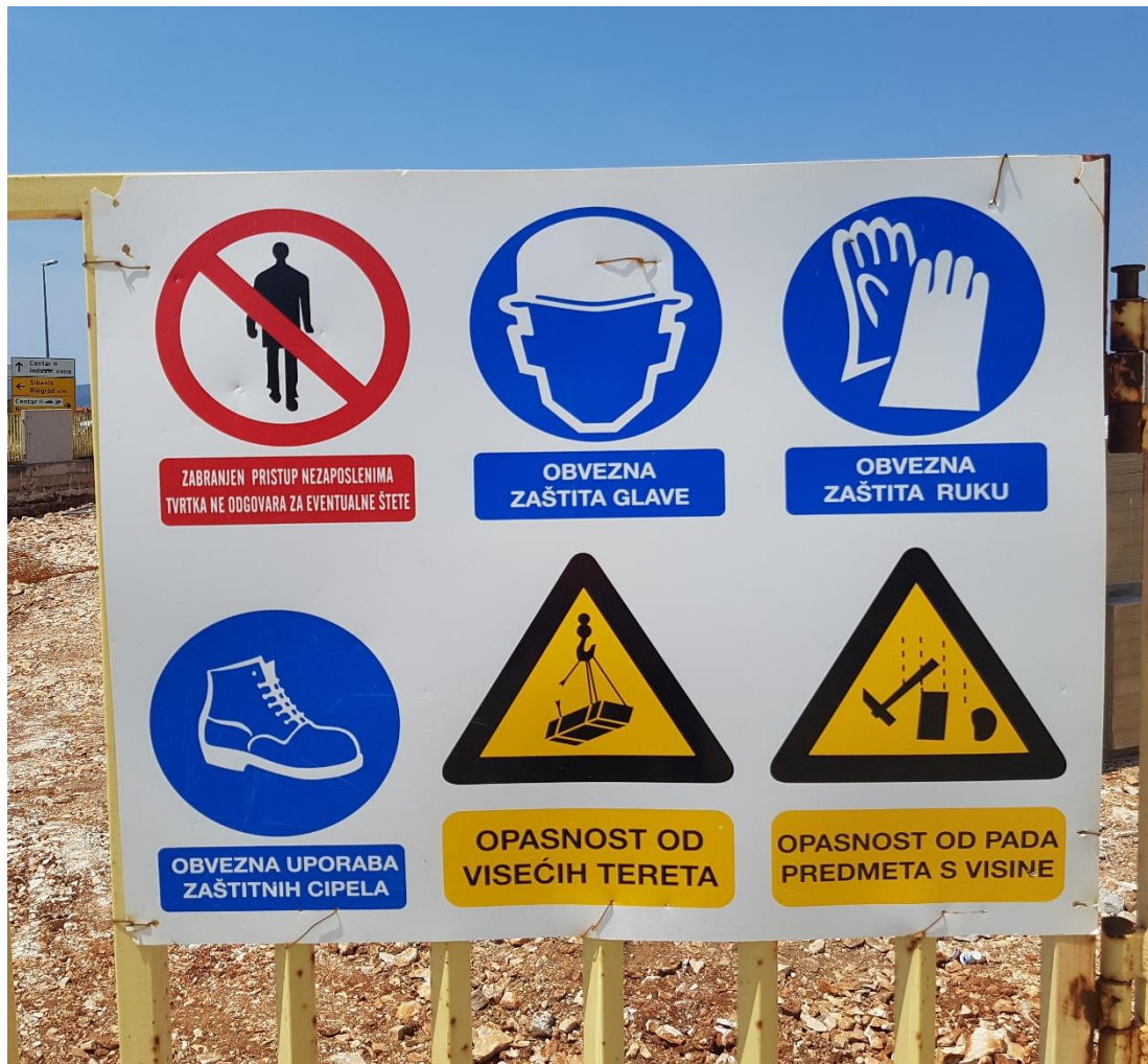
Sl. 4. Znakovi sigurnosti postavljeni na ulazu u gradilište
