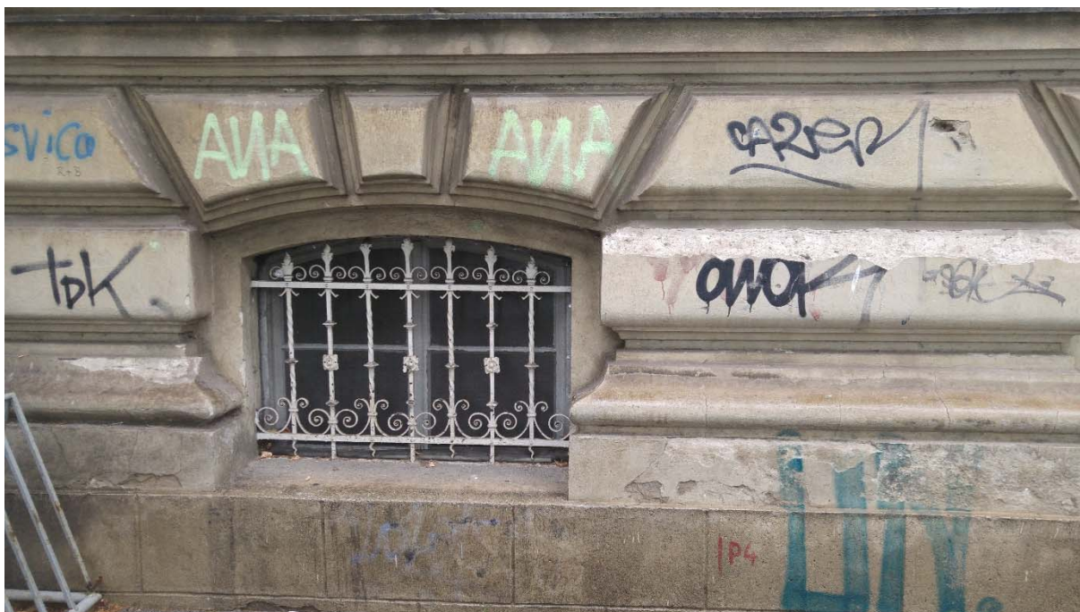
Slika 10: Predodžba vanjskog dijela zgrade: rešetke na podrumskim prostorijama: Izvor autora
