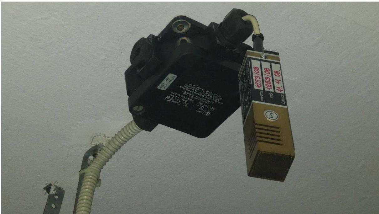
Slika 19: Predodžba plinodojavnog detektora tzv. "njuškalo": Izvor autora
