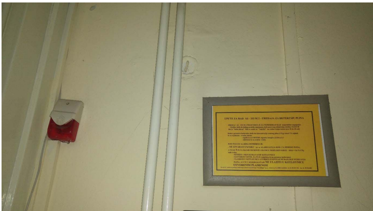
Slika 14: Predodžba natpisa i alarmnog senzora za detekciju plina sa uputama: Izvor autora
