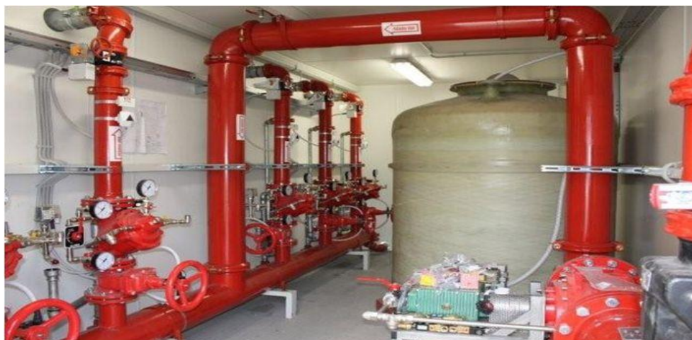
Slika 8. Sprinkler stanica [14]
