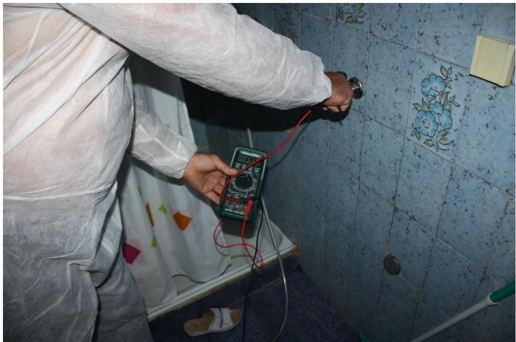
**Slika 33:** Ispitivanje električnih uređaja korištenjem digitalnog multimetra [20].
