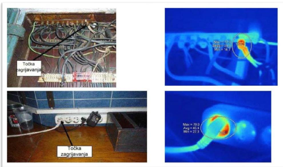
Slika 3: Primjer "točki zagrijavanja" na kritičnim mjestima(snimljeno termovizijskom kamerom<sup>6</sup>) [12].
