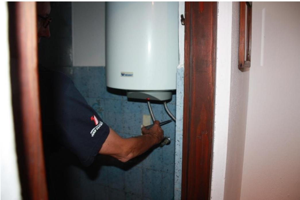
**Slika 32:** Ispitivanje električnih uređaja (uređaj za zagrijavanje vode) [20].
