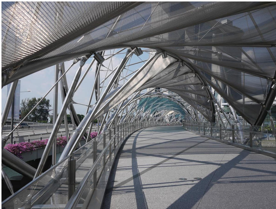
Slika 2. Helixov most u Singapuru izrađen od nehrđajućeg čelika [6]
