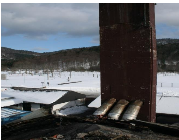
Sl.11. Dimovodne cijevi i dimnjak [15] Sl.12. Potpuno uništena unutrašnjost [15]
