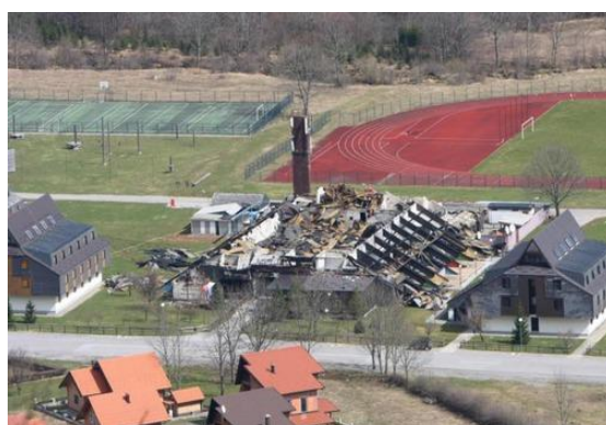
Sl.14. Kotlovnica i dimnjak [15]
