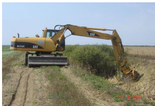
Slika 6. Tarupiranje kanala (Izvor: www.vodoprivredavinkovci.com )
