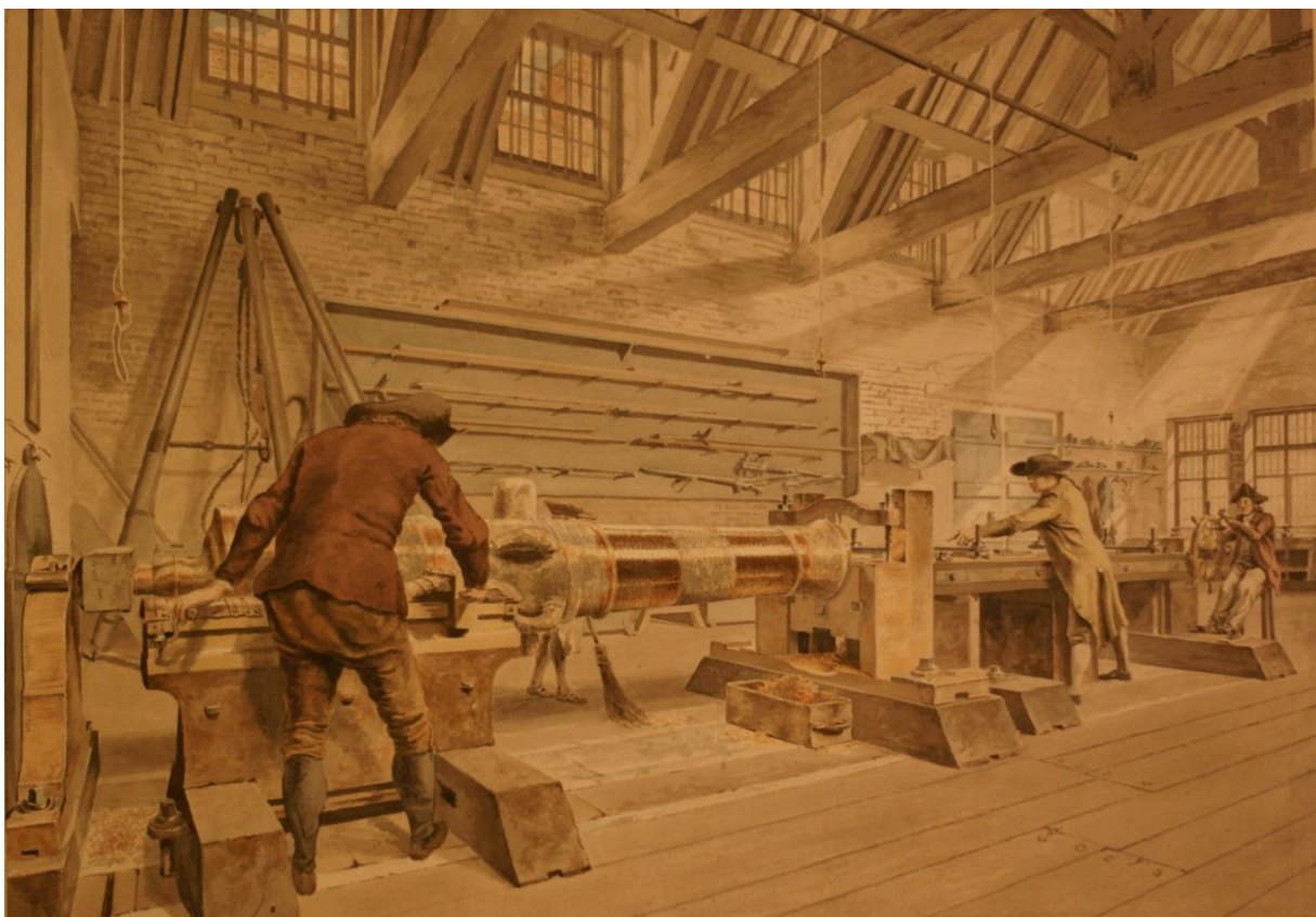
Slika 2 Horizontalna bušilica u Woolwich-u [4]
