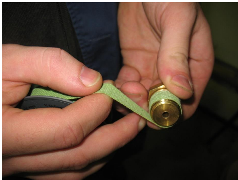
Slika 18. - Namatanje teflonske trake za brtvljenje na priključak
