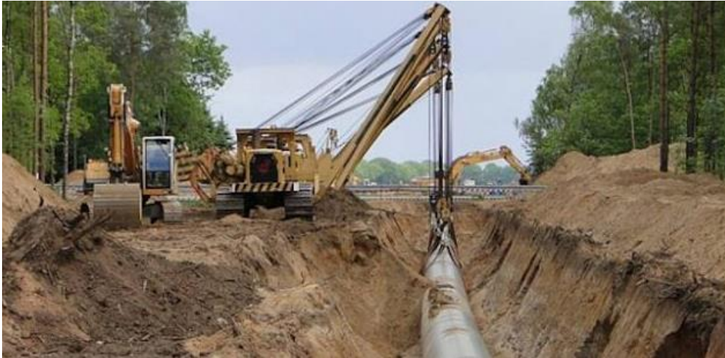
Slika 7. - Polaganje plinovoda u zemlju
