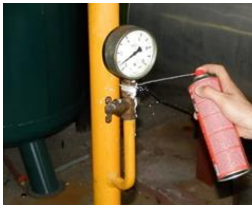
Slika 30. - Provjera spoja pjenušavim sredstvom
