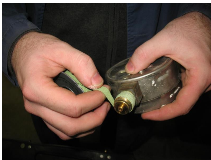
Slika 25. - Namatanje teflonske trake na navoj manometra
