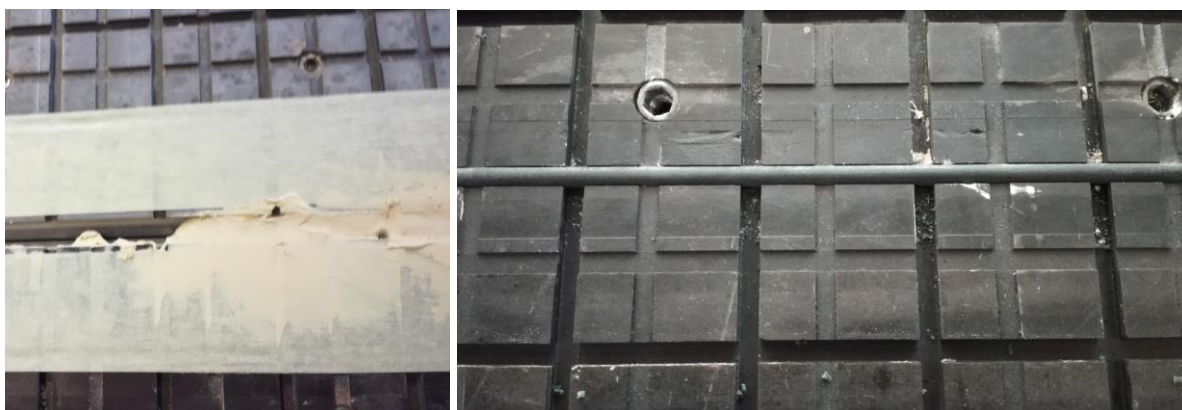
Slika 142. Popravak oštećenja (lijevo), pregledano i obojano (desno)
