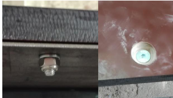
Slika 83. Stegnute ploče odozdo (lijevo) i odozgo (desno)
