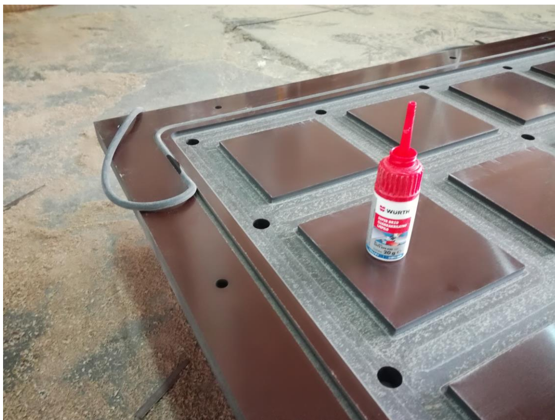
Slika 61. Lijepljenje gumene brtve u komoru vakuum stola
