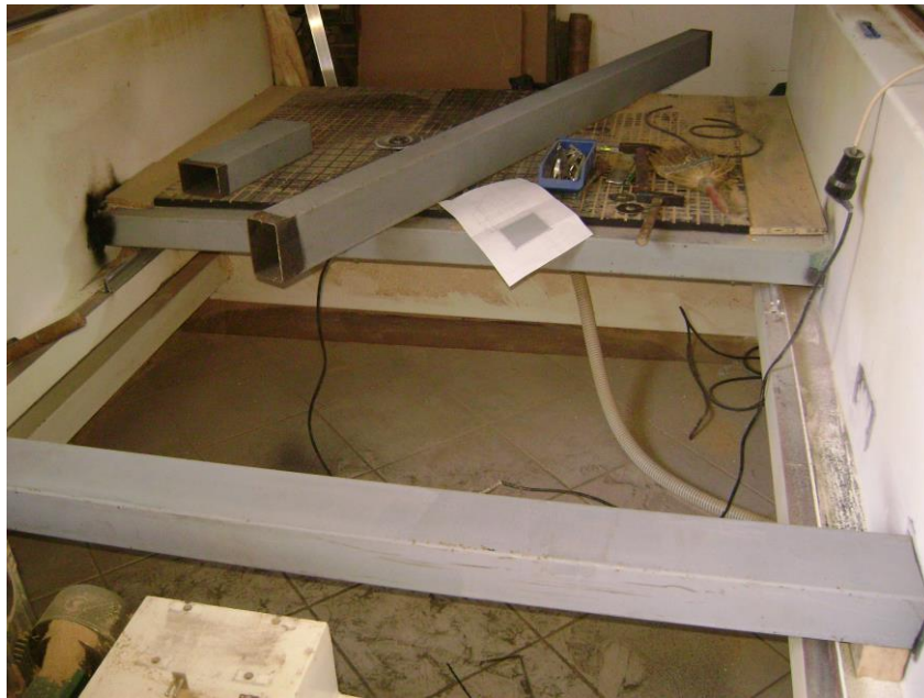
Slika 91. Proces zavarivanja dodatnih cijevi
