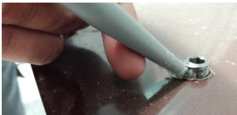
Slika 69. Silikoniranje vanjskog navoja trio matice
