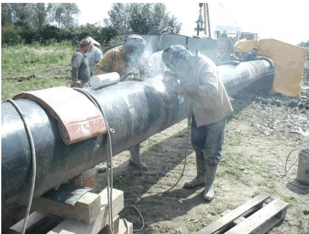
Slika 5. REL zavarivanje cjevovoda [4]
