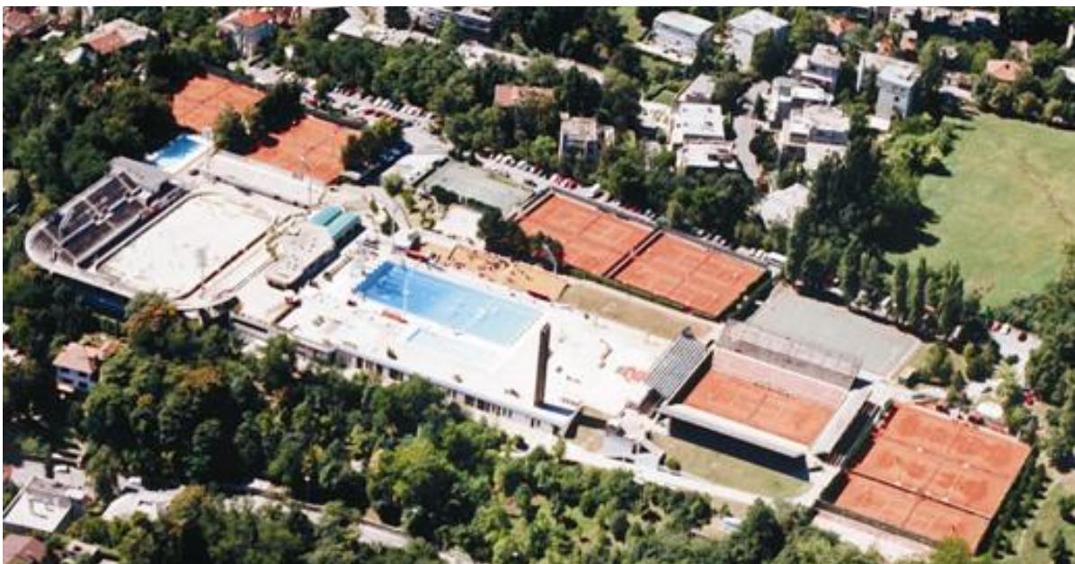
Slika 4: Bazen u sklopu klizališta
