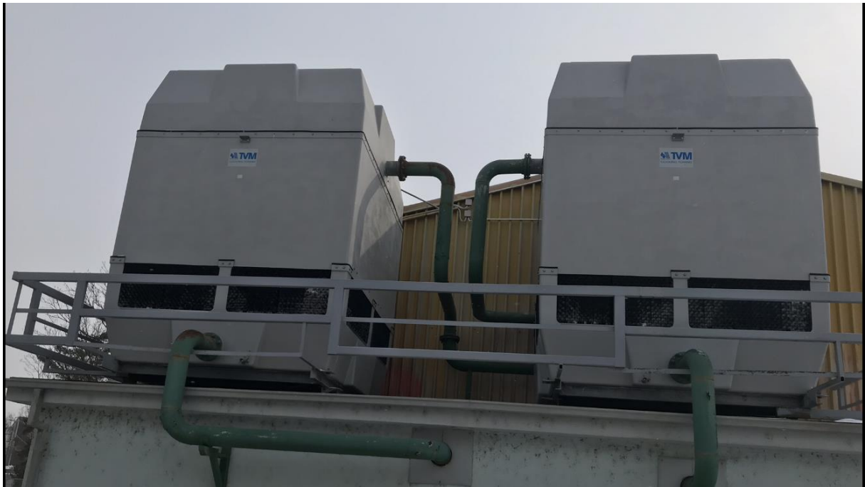
Slika 5: Rashladni tornjevi
