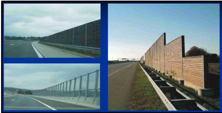
Slika 10. Primjeri zaštite od buke [9]
