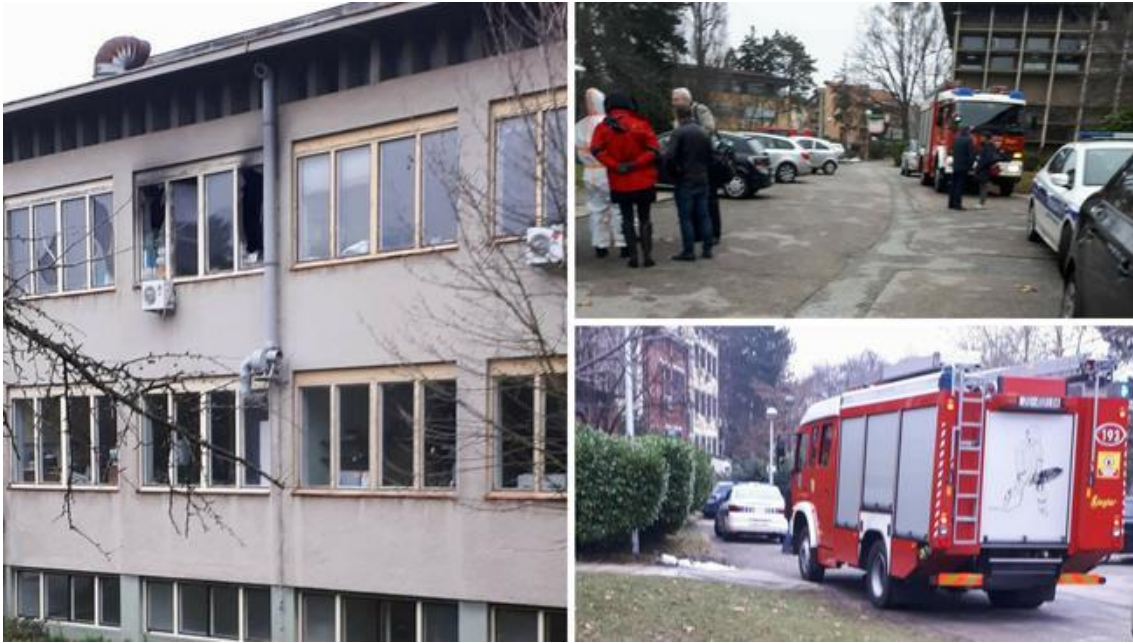
Slika 5. Laboratorij Instituta Ruđer Bošković nakon što je ugašen požar.
