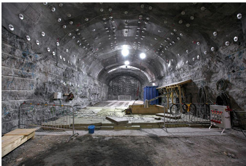
Sl. 24 Odlagališna galerija (Odlagalište Onkalo)
