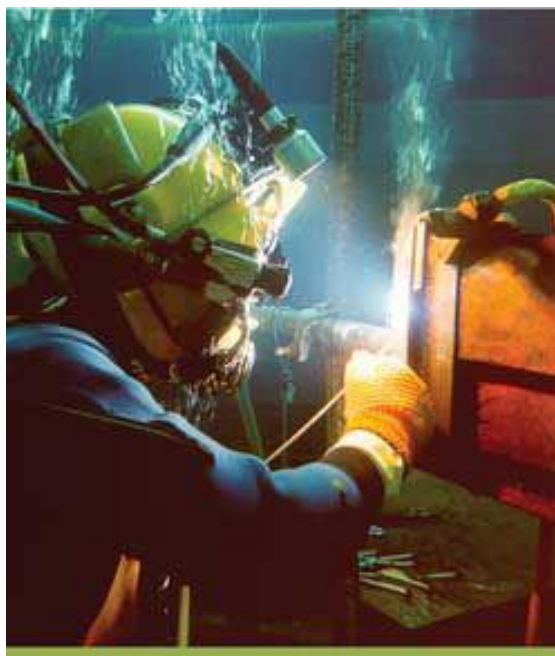
Slika 8. Primjer mokrog podvodnog zavarivanja[31]
