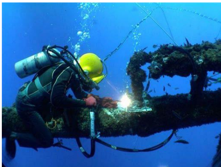
Slika 4. Mokro podvodno zavarivanje[4]
