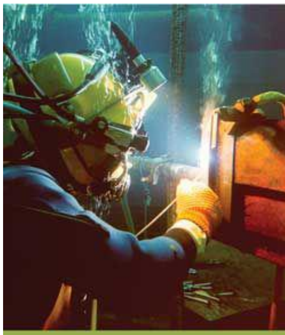
Slika 8. Primjer mokrog podvodnog zavarivanja[31]
