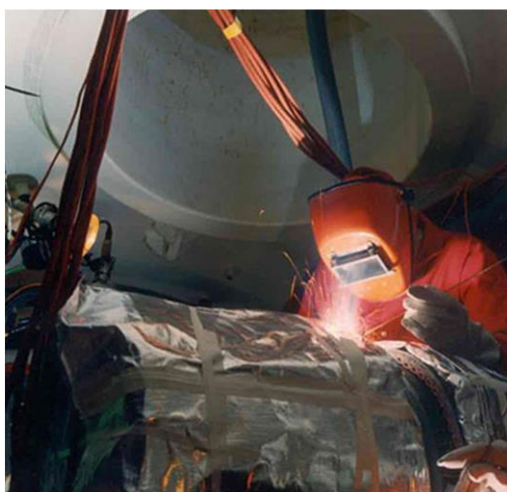
Slika 3. Zavarivanje u suhoj hiperbaričkoj komori[3]
