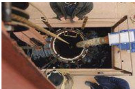
Slika 7. Atmosfersko podvodno zavarivanje[30]
