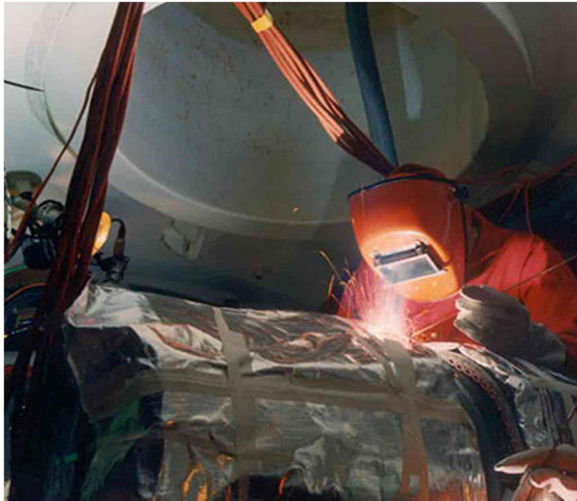
Slika 1. Suho podvodno zavarivanje [3]
