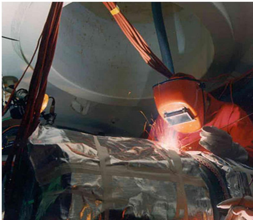
Slika 1. Suho podvodno zavarivanje [3]
