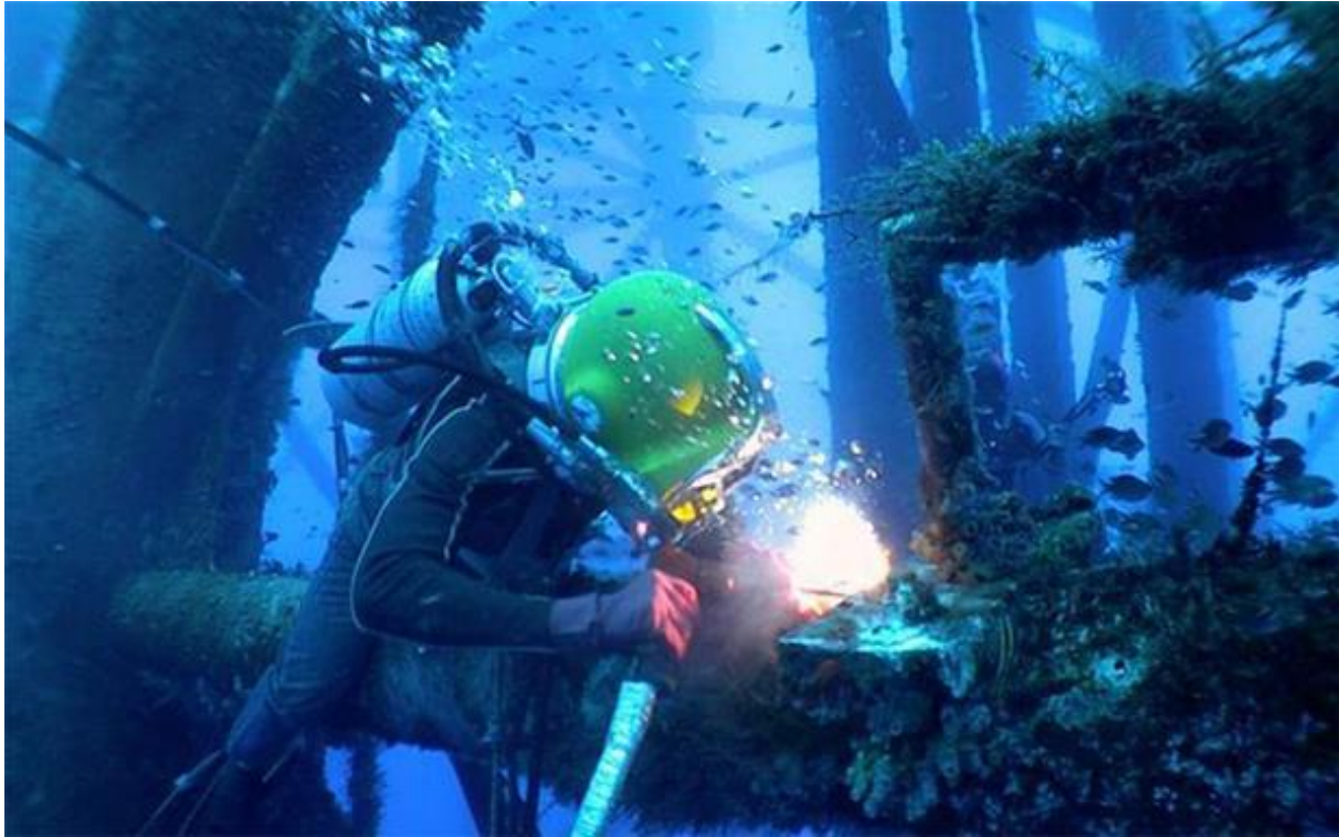
Slika 2. Moko podvodno zavarivanje [4]
