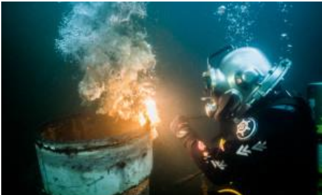
Slika 11. Zavarivač tijekom podvodnog mokrog zavarivanja [4]
