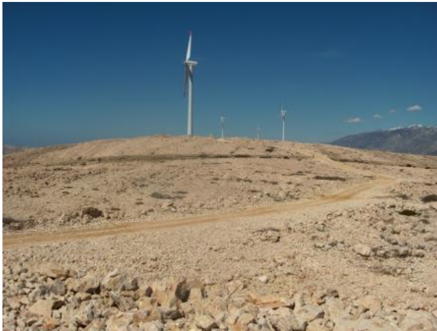
Slika 2. Vjetroelektrana Ravne 1 na Pagu.
