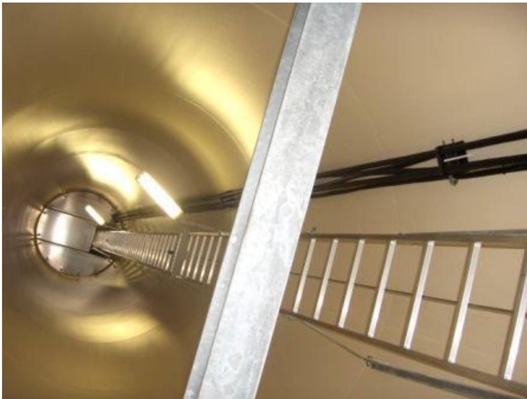
Slika 14. Unutrašnjost stupa vjetrogeneratora
