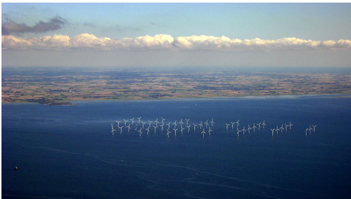
Slika 23. Priobalna vjetroelektrana Lillgrund (Švedska).
