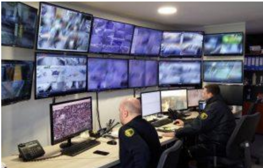
Slika 19. Predodžba centralnog dojavnog sustava
