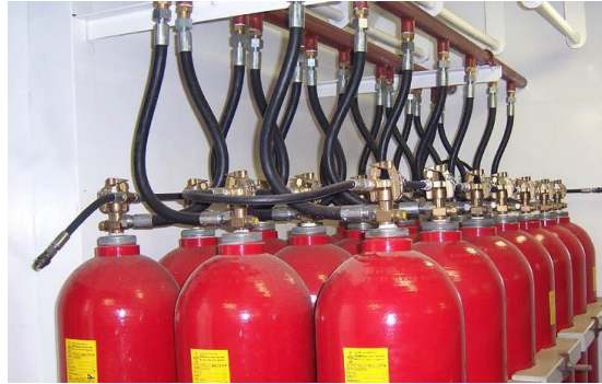
Slika 13. Baterija boca s ugljikovim dioksidom [16]
