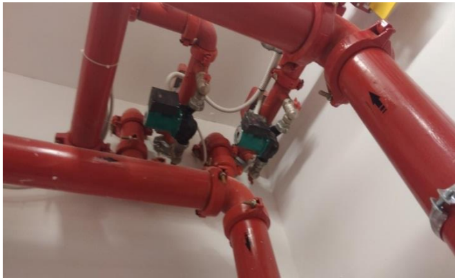
Slika 29. Elektro pumpe radna i rezervna (lijevo) te jockey pumpa-napojna (desno) [10]
