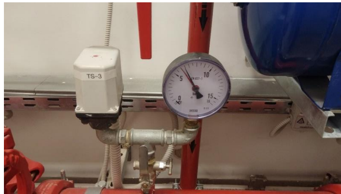
Slika 35. Tlačna sklopka- lijevo i manometar- desno [10]
