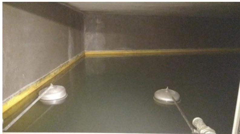
Slika 27. Akumulacijski spremnik (sprinkler bazen) [10]
