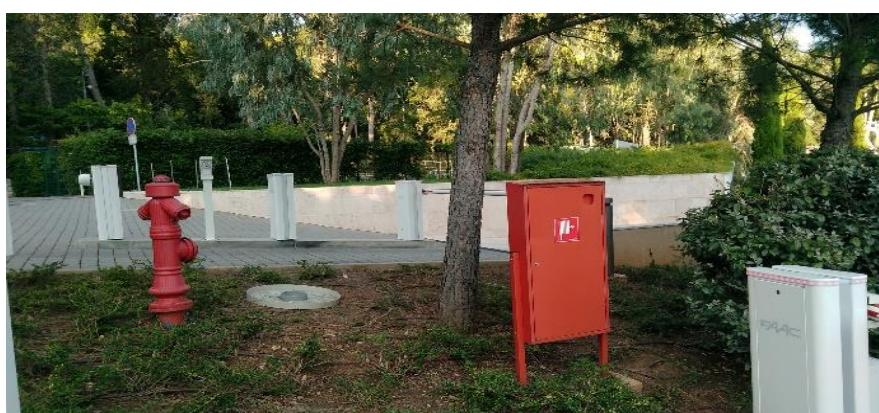
Slika 19. Vanjska hidrantska mreža oko objekta-nadzemni hidrant s opremom [10]
