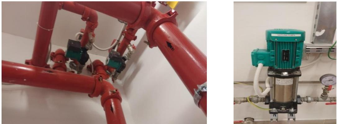
Slika 29. Elektro pumpe radna i rezervna (lijevo) te jockey pumpa-napojna (desno) [10]
