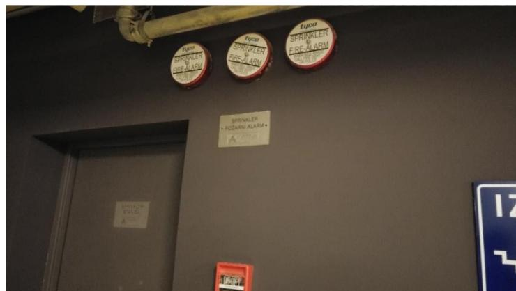
Slika 34. Hidraulična alarmna zvona i sirena [10]
