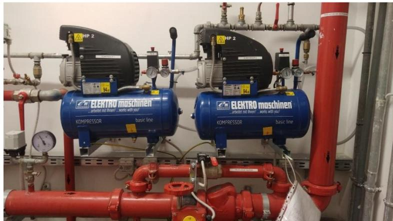
Slika 33. Kompresori za potrebe suhog sprinkler sustava [10]
