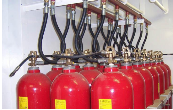
Slika 13. Baterija boca s ugljikovim dioksidom [16]
