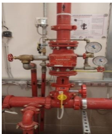
Slika 30. Mokri sprinkler ventil u stanici [10]
