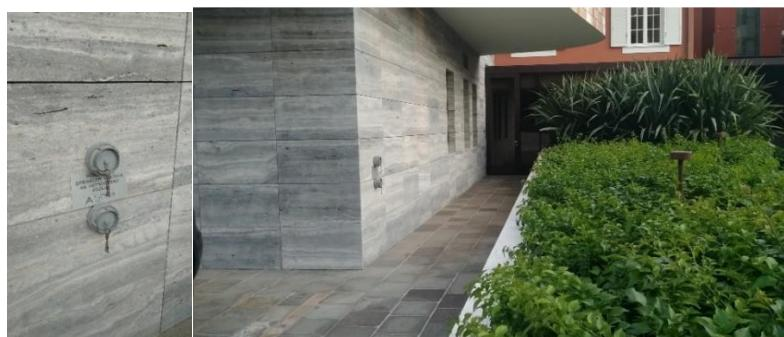
Slika 28. Priključak na objektu za vatrogasno vozilo pored glavnog ulaza u objekt [10]
