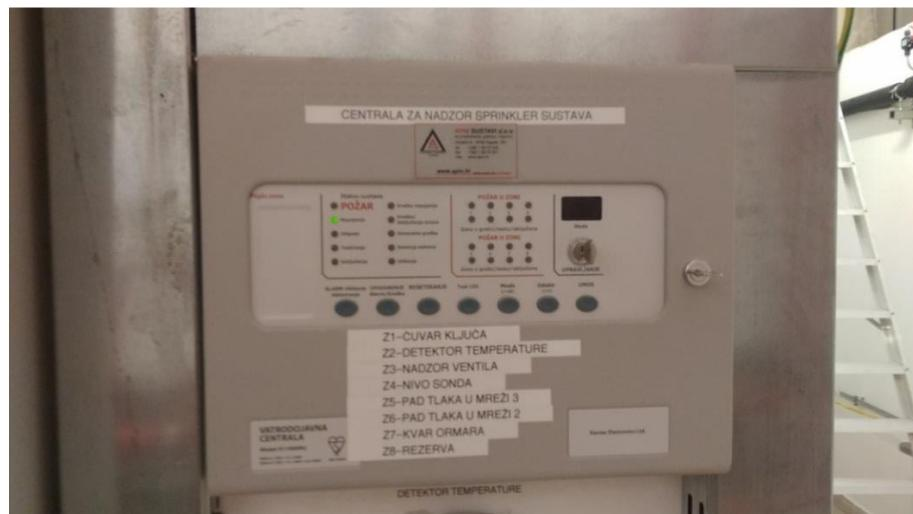
Slika 20. Centrala za nadzor sprinkler sustava [10]
