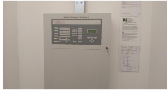
Slika 21. Vatrodjavni sustav-centrala [9]
