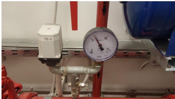
Slika 35. Tlačna sklopka-lijevo i manometar-desno [10]
