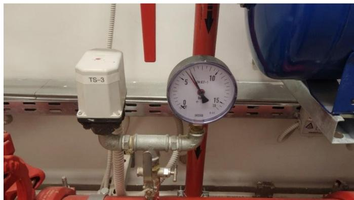
Slika 35. Tlačna sklopka-lijevo i manometar-desno [10]
