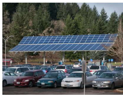
Slika 28. Primjer parkinga sa solarnim ćelijama za punjenje elektroauta
