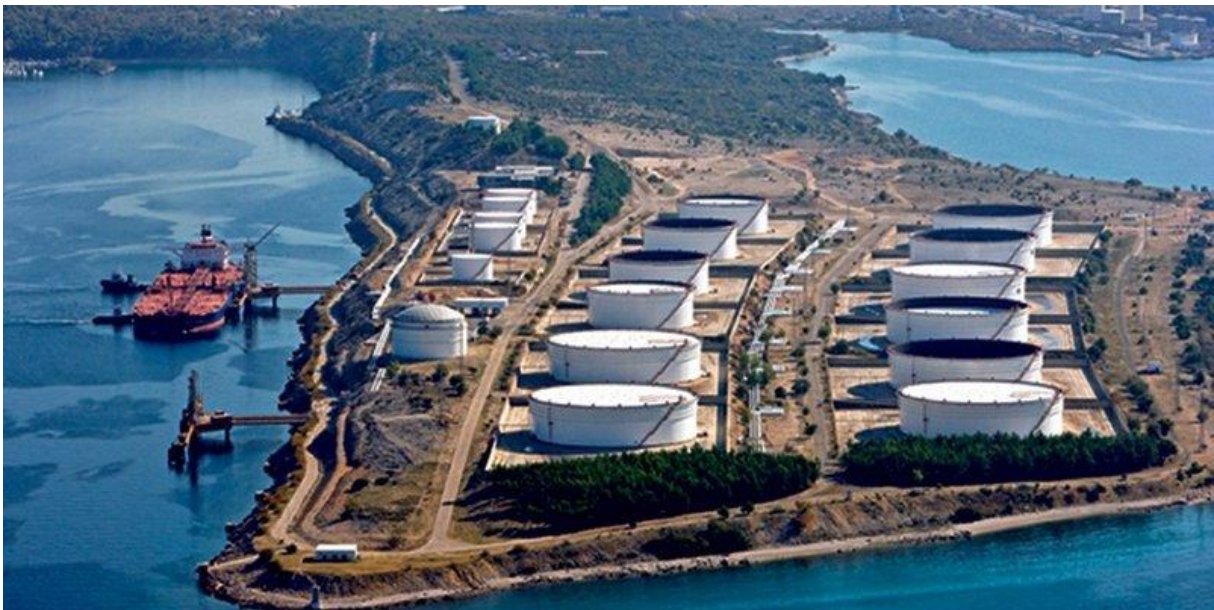
Slika 2.: Terminal i luka Omišalj [4]
