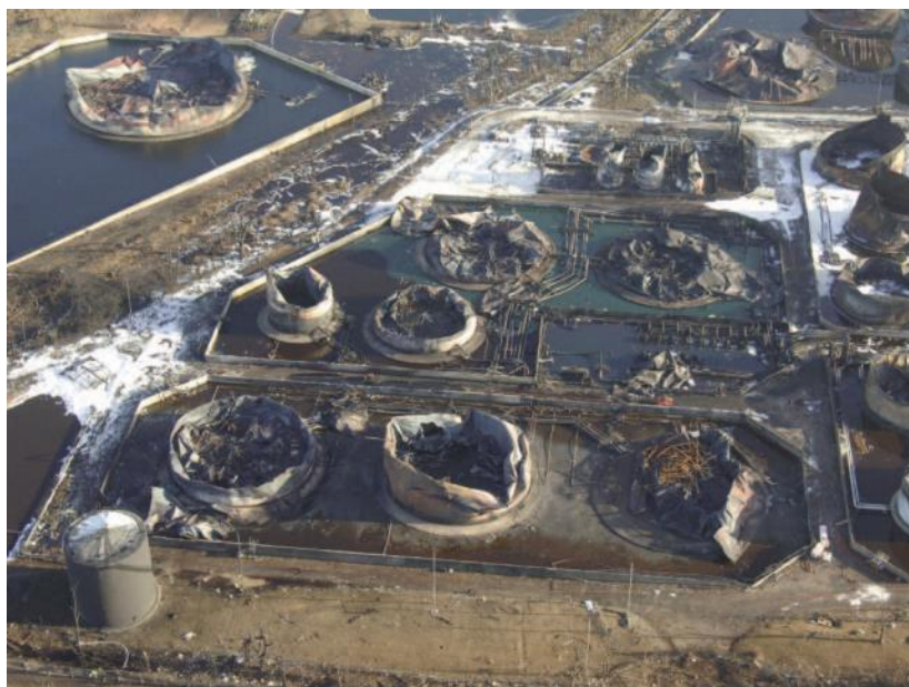
Sl. 19. Ostaci terminala nakon požara [9]
