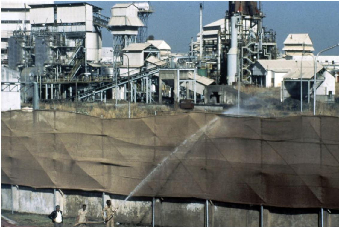
Slika. 32. Postavljanje mokrog platna oko postrojenja
