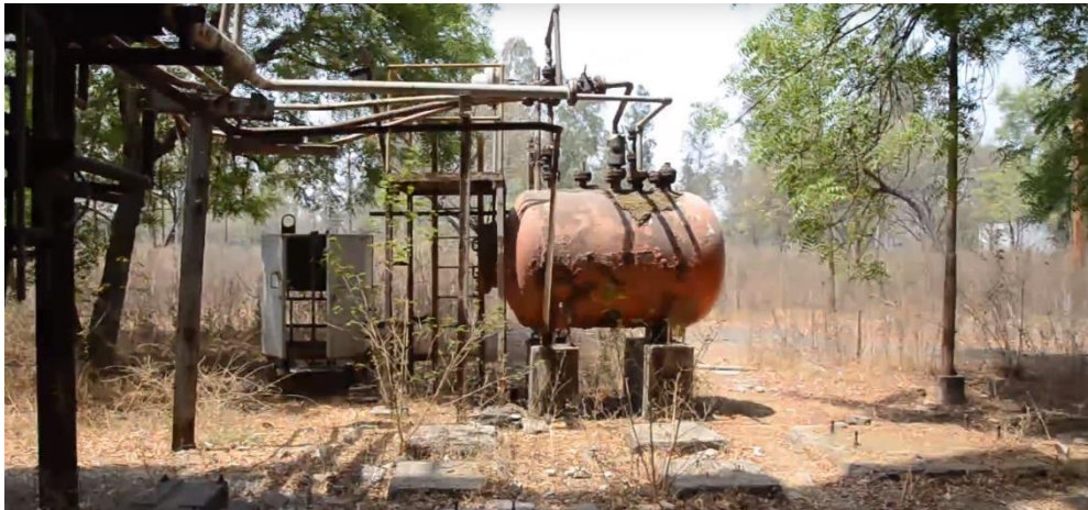
Slika 35. Neuklonjeni spremnik Fozgen-a [21.]
