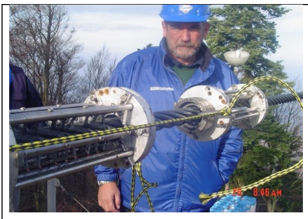
Slika 9: Strojno čišćenje čeličnog užeta
