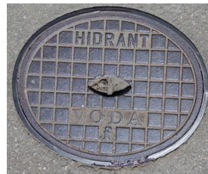
Slika 10. Podzemni hidrant [22]
