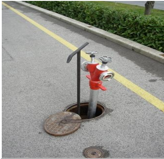
Slika 24. Hidrantski nastavak spojen na podzemni hidrant [18]
