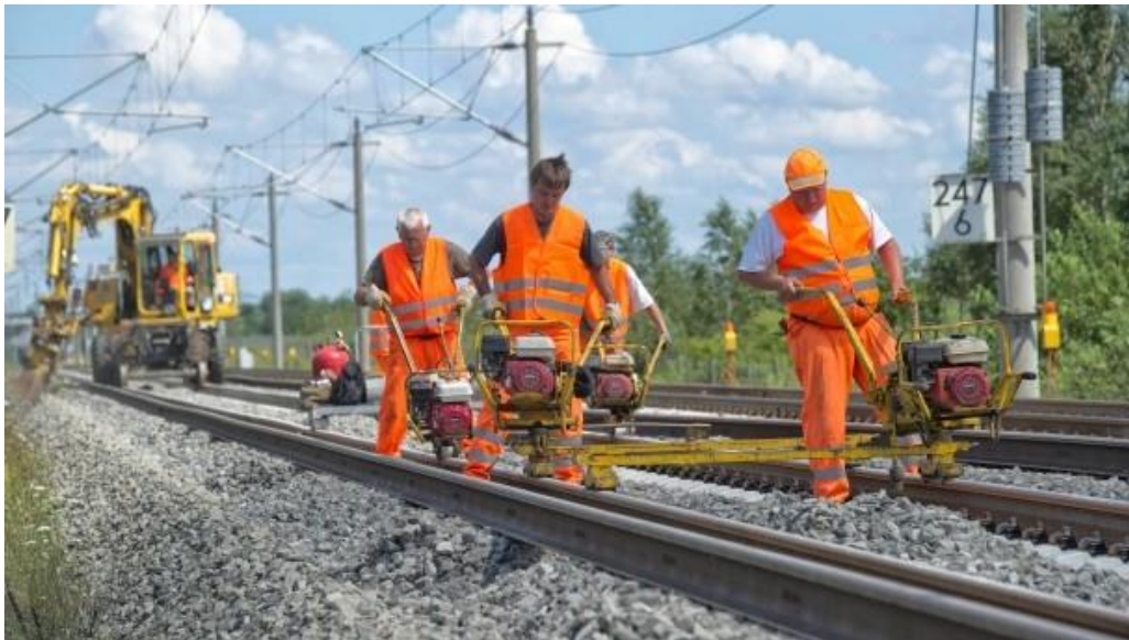
Slika 2: Radovi na pruzi
