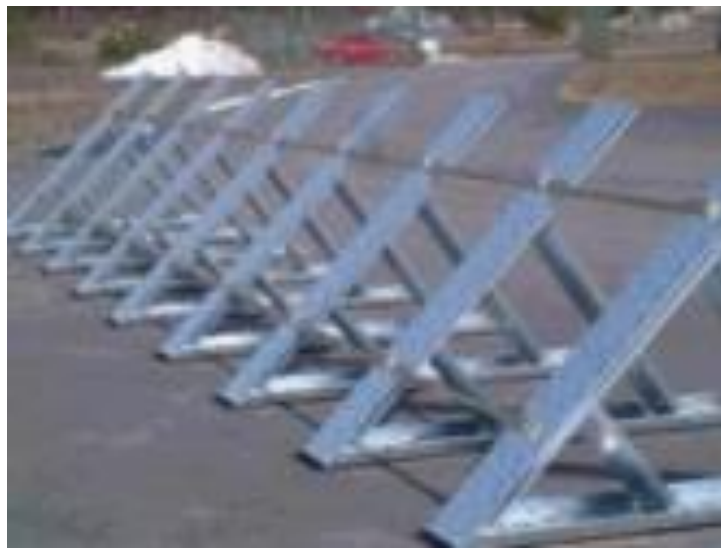
Slika 4. Nosачi su spojeni pomoću vodoravnih profila [3]
