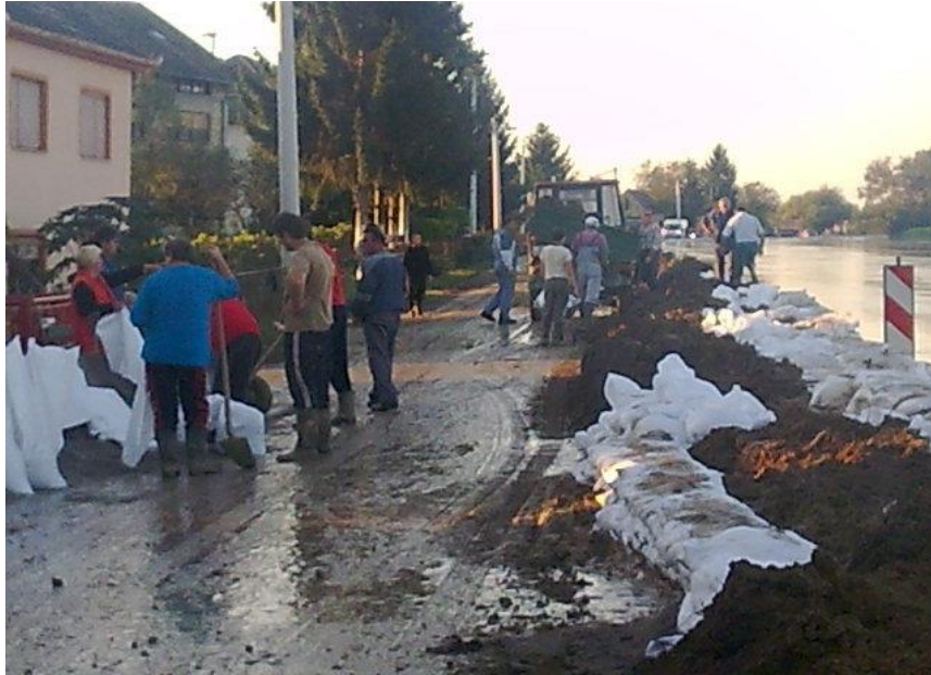
Slika 38. Rijeka Sava 20.09.2010. – izrada tzv. „zečjih nasipa“ [12]
