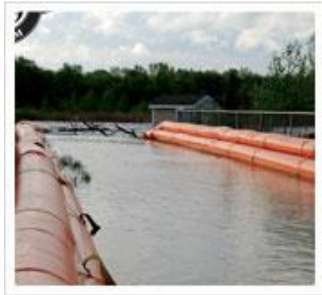
Slika 25. Tigar brana prikazana u ravnom položaju [6]
