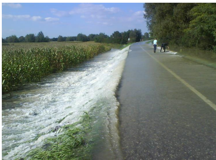
Slika 34. Rijeka Sava prelijeva preko nasipa [12]
