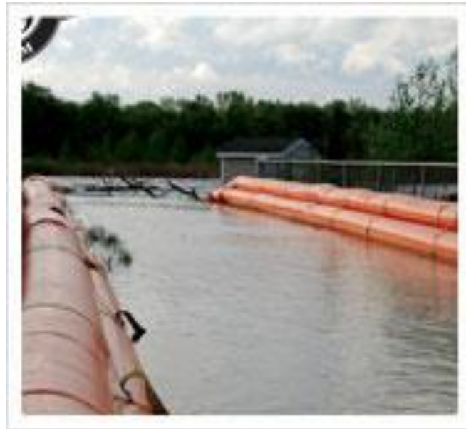
Slika 25. Tigar brana prikazana u ravnom položaju [6]
