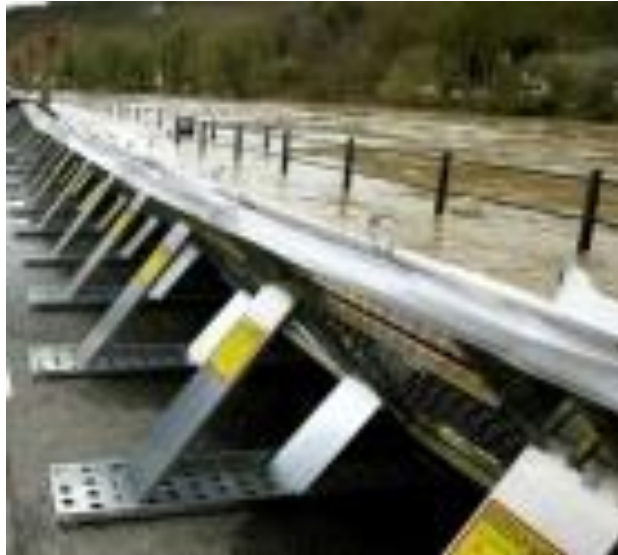
Slika 2. Geodesign pregrada postavljena radi usmjeravanja nabujalih voda [3]
