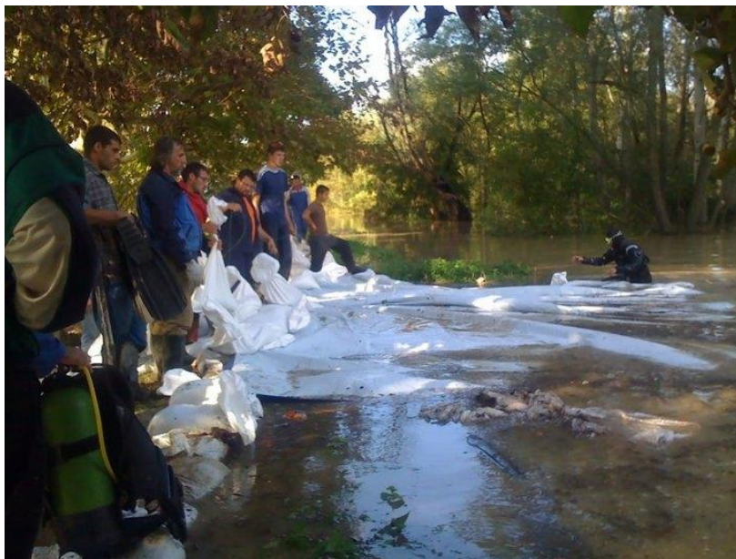
Slika 35. Ronionci postavljaju zaštitnu foliju poradi propusta nasipa [12]
