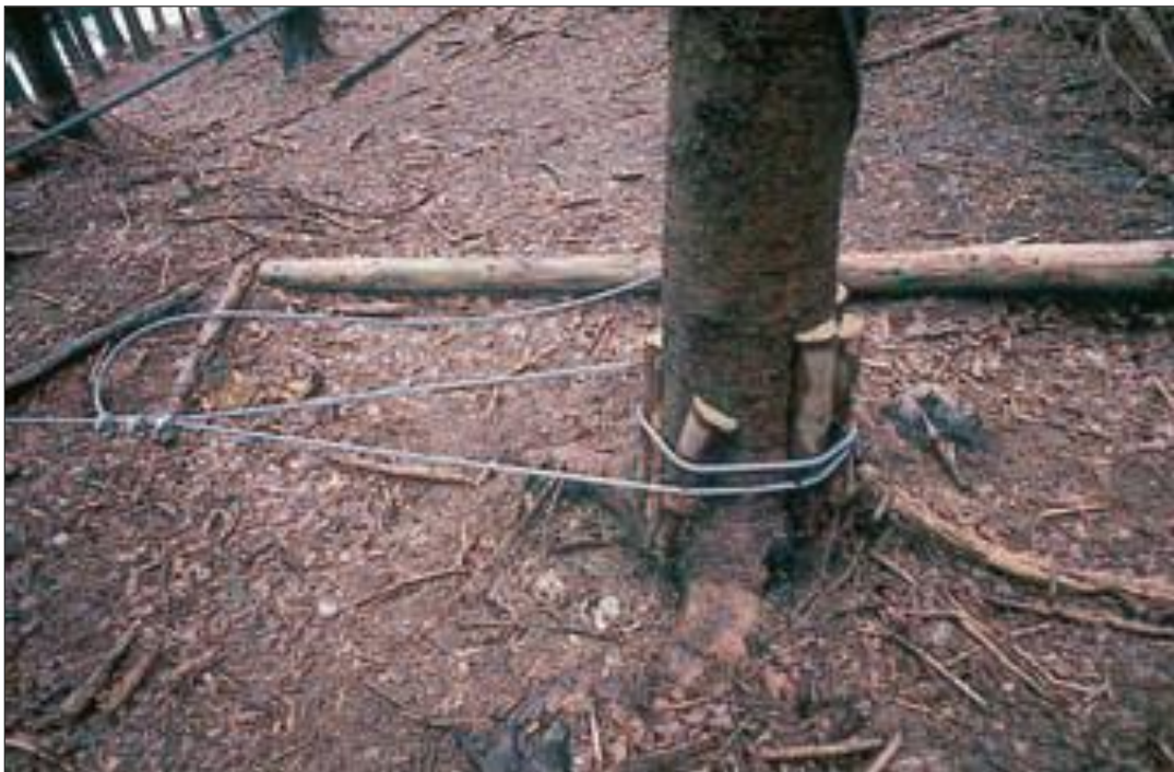
Slika12: Sidrenje užeta na stablo (Seilgelaender_kroat_web(2).pdf)
