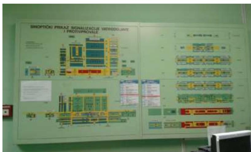
Sl. 11. Sinoptički prikaz vatrodojave i protuprovalne zaštite u kontrolnom centru [13]
