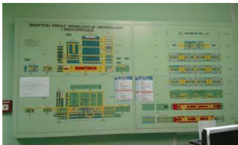
Sl. 11. Sinoptički prikaz vatrodjave i protuprovalne zaštite u kontrolnom centru [13]
