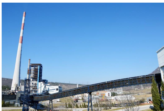
Slika 5. Traka kojom ugljen dolazi na deponij. [10]
