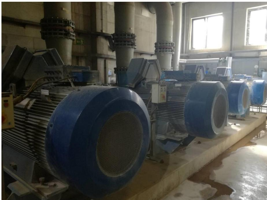
**Slika 26. Motori pumpa suspenzije vapnenca: snage 355 kW i 315 kW (ovisno na koju visinu pumpaju).**
