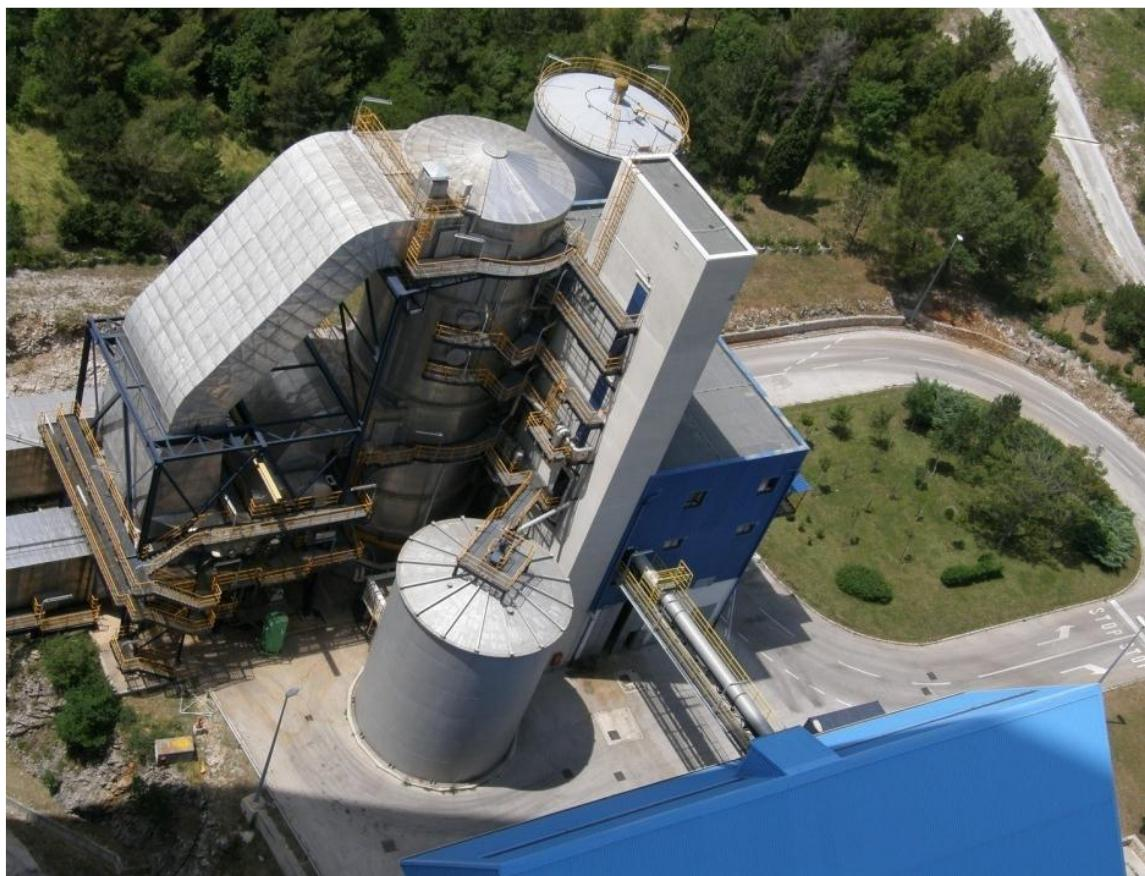
Slika 24. Postrojenje za odsumporavanje dimnih plinova, REA.
