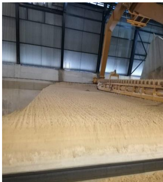
Slika 31. Nagomilavanje gipsa strugalom.
