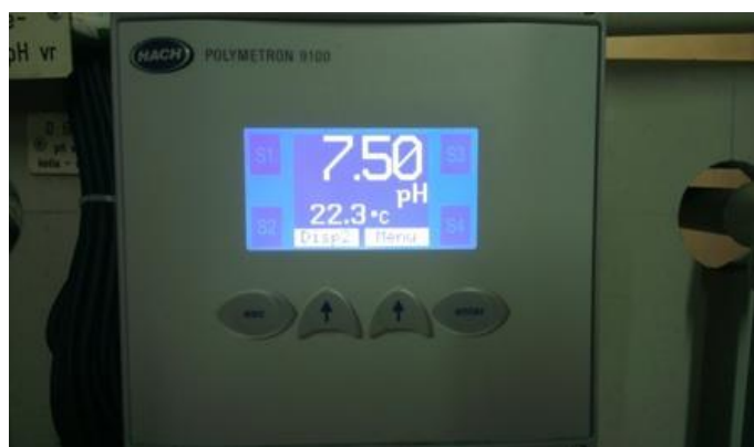
Slika 17. Pročišćena voda nakon pješčanih filtera.
