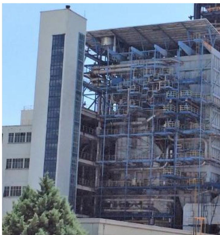
Slika 11. Generator pare TE Plomin 1.
