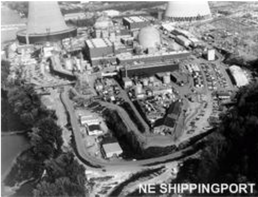
Slika 10. NE pri obustavi rada scenarijem SAFSTOR
