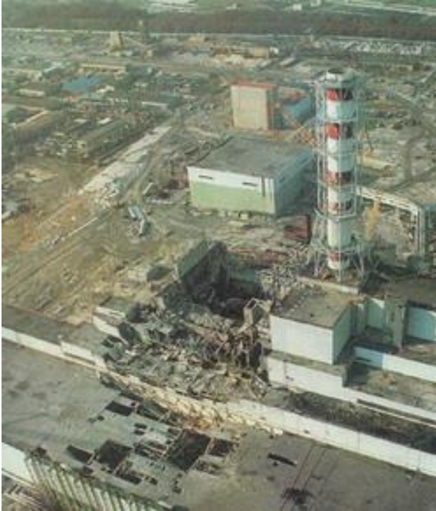
Slika 14. Nuklearni reaktor broj četiri nakon eksplozije. Vidljiva su znatna oštećenja reaktora (u sredini) i generatorske zgrade (dolje).
