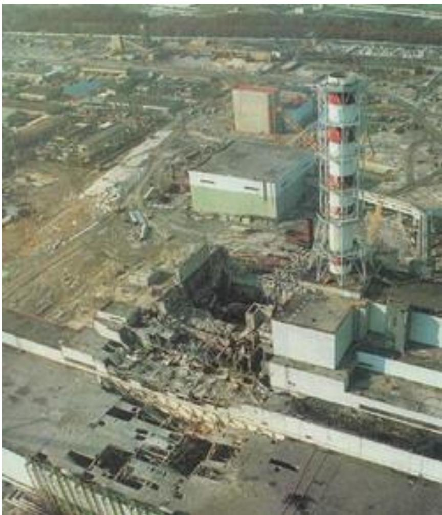
Slika 14. Nuklearni reaktor broj četiri nakon eksplozije. Vidljiva su zнатна оштећења reaktora (у средини) и generatorske zgrade (долje).
